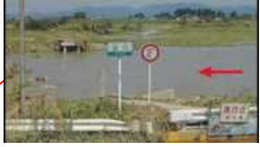
流出した間中橋 (H14.7洪水)
