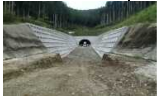
③県道改良工事(H28.9工事中)
