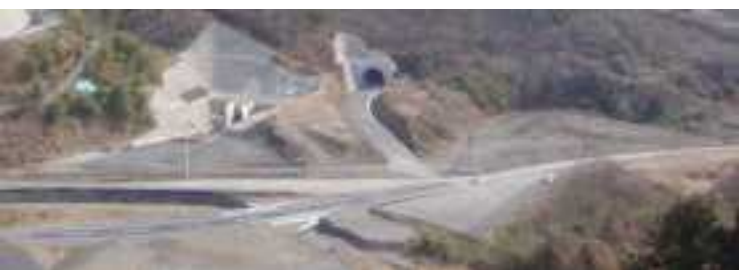
④仮排水路・放流管敷設トンネル呑口(上流側坑口) (H23.3 竣工)
