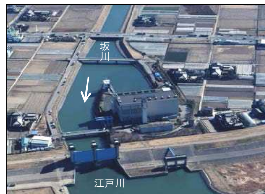
北千葉導水路の稼働により、江戸川へ導水している状況
