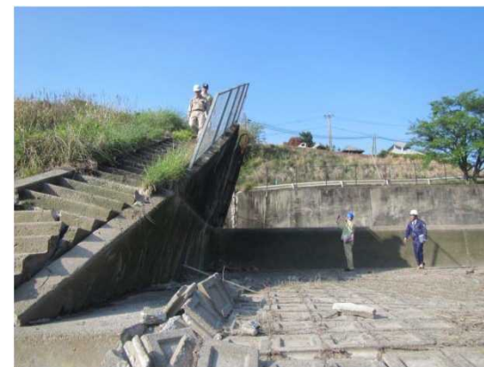
堤体のひび割れ
