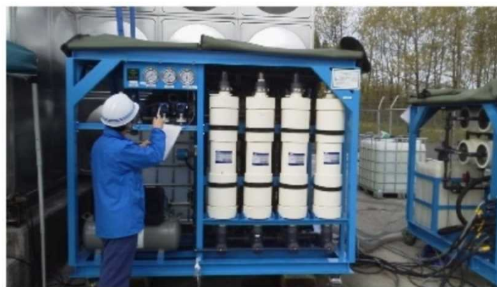
＜可搬式浄水装置操作状況＞
