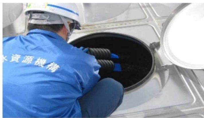
＜給水槽への浄化水注入状況＞
