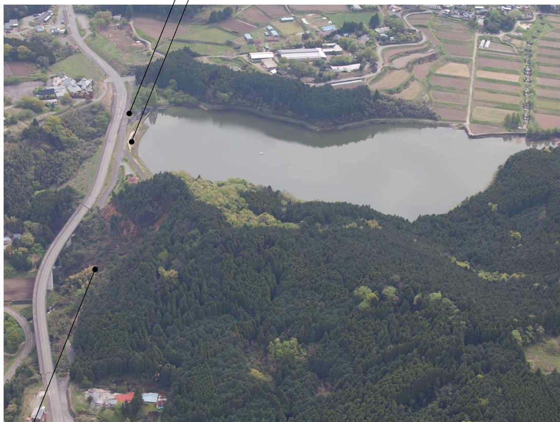
地山(背面側)の崩壊
