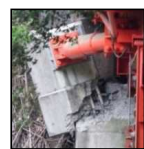
南阿蘇橋（被災前） 制震ダンパー取り付け部の損傷
