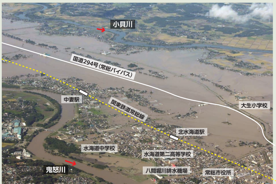
鬼怒川の氾濫による被災状況
