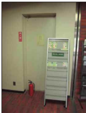
防火扉の前に置かれた消火器
