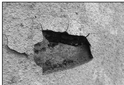
鉄筋の腐食
