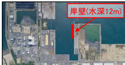
茨城港常陸那珂港区中央ふ頭地区 国際物流ターミナル整備事業
