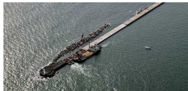
H28.3 相馬港沖防波堤工事状況
