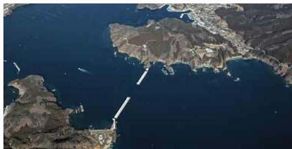
H29.2 大船渡港湾口防波堤全景
