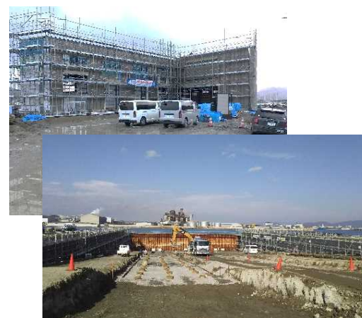
整備中の造船工場(石巻市)
