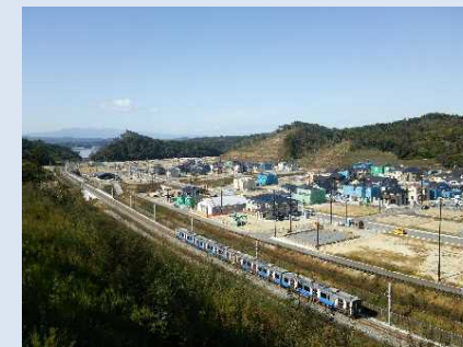
移設したJR仙石線と高台住宅地(H28. 11撮影)
