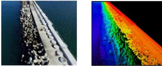
GPSデータや測量データから構造物の移動、沈下、陥没等の位置と数値を自動的に把握。
