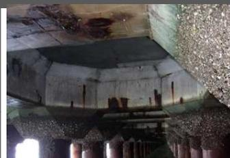
目視による錆汁の染み出しの確認により、鉄筋腐食状況を把握。
