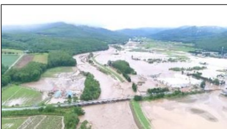
石狩川水系空知川 堤防決壊 (南富良野町)
