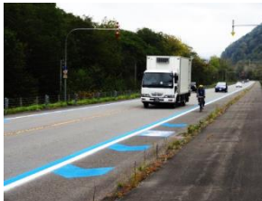
車道への通行位置明示
