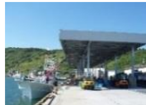
屋根付き岸壁の整備
