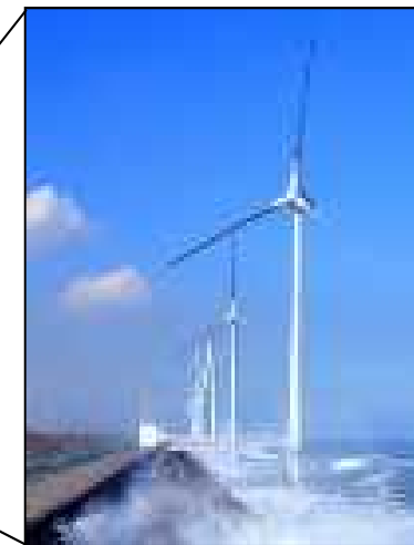
洋上風力発電施設
