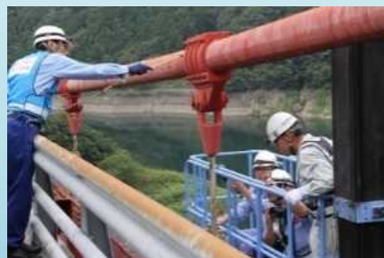
▲ 国道メンテナンス
