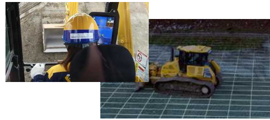
ICT建機による施工
