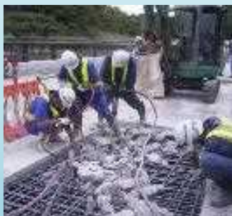
▲ 修繕・耐震補強
