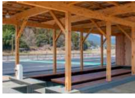
運転の疲れを癒やす足湯 (道の駅 もっくる新城)
