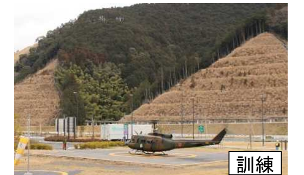
新東名 静岡SAにおけるヘリポートの整備
