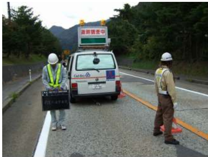
(コンクリート舗装における FWD たわみ量調査)
