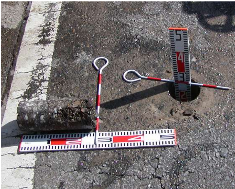
(アスファルト舗装におけるコア抜き調査の実施例)
