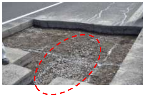
路盤の損傷の例 (路盤の細粒分がポッピングにより流失し、碎石が集まっている状況)
