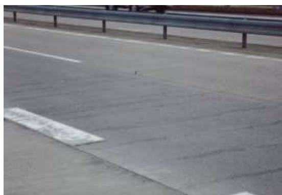
(連続鉄筋コンクリート舗装で健全と診断される横断ひび割れの例)
