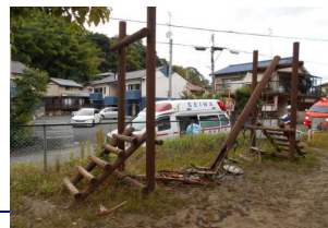
老朽化により破損した遊具
