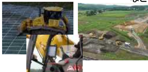
ICT建機での施工
