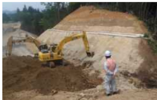
MCバックホーに よる切土法面整形
