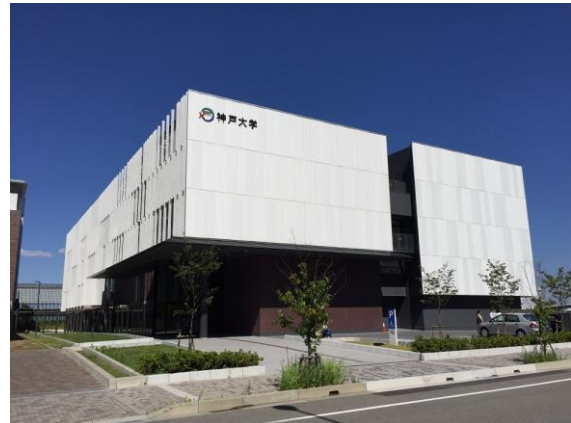
神戸 GMP 施設 (神戸大学統合研究拠点内) 提供：次世代バイオ医薬品製造技術研究組合
