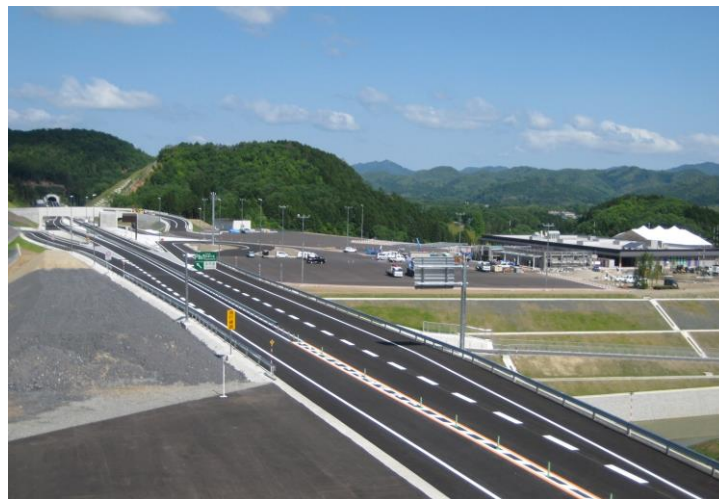
京都縦貫自動車道 (京丹波 PA 付近)
