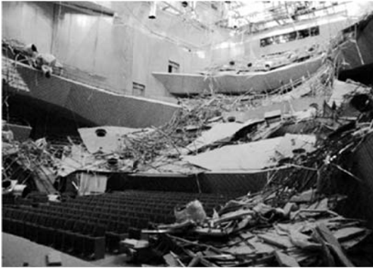
ホール天井の脱落
