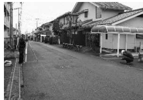
【現況測量の様子】
