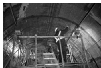
繊維シート貼付
