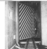
防水ゲート整備
