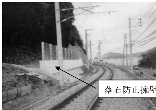
【落石防止擁壁の一例】
