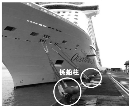
大型クルーズ船に対応した係船柱・防舷材の設置
