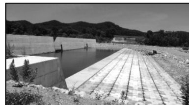
再度災害防止のため砂防堰堤等を整備
