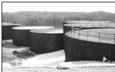
樽前山における砂防堰堤の整備
