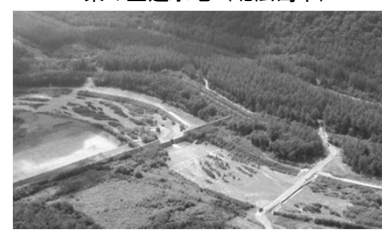
美瑛川第8号砂防堰堤(美瑛町)
