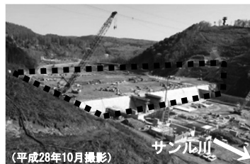
工事中のサンルダム
