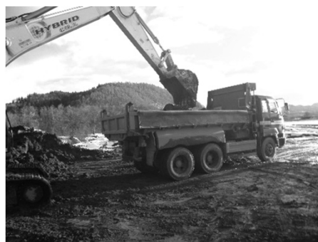
常呂川の河道掘削土の積込状況
