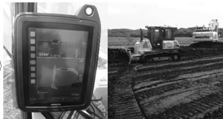
ICT建機による施工
