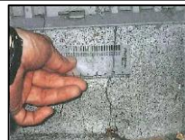
水平器による柱の傾きの計測
