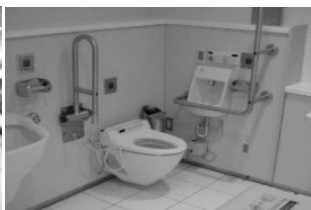
障害者対応型トイレ
