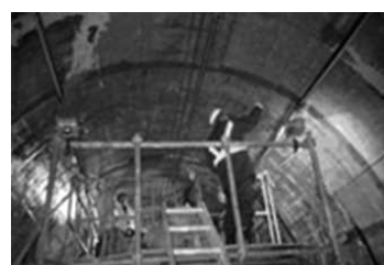
繊維シート貼付
