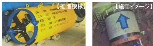
・道路を掘り返さずに下水管を新設する工法
