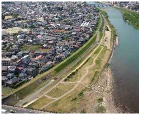
河川堤防の整備
