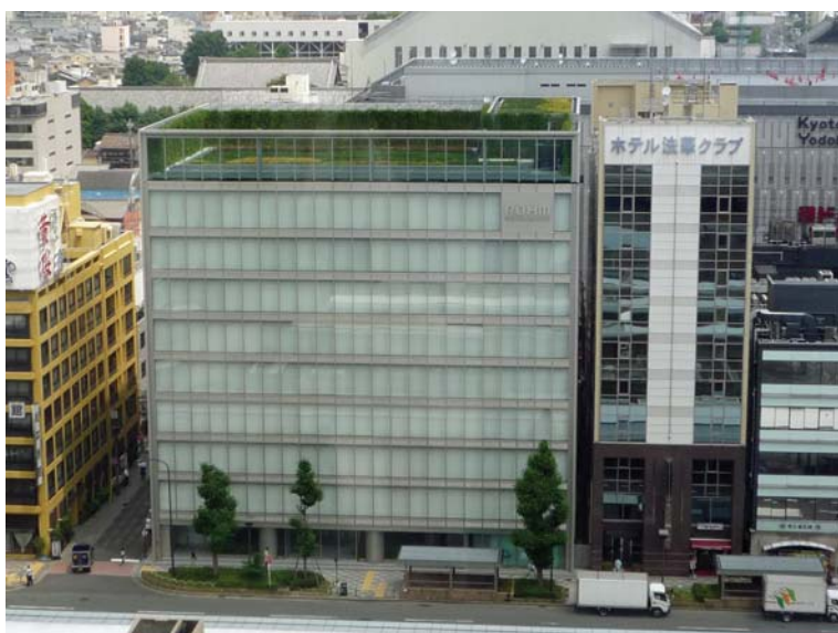
建物の南側正面全景。京都駅から美しい緑を望むことができる。
