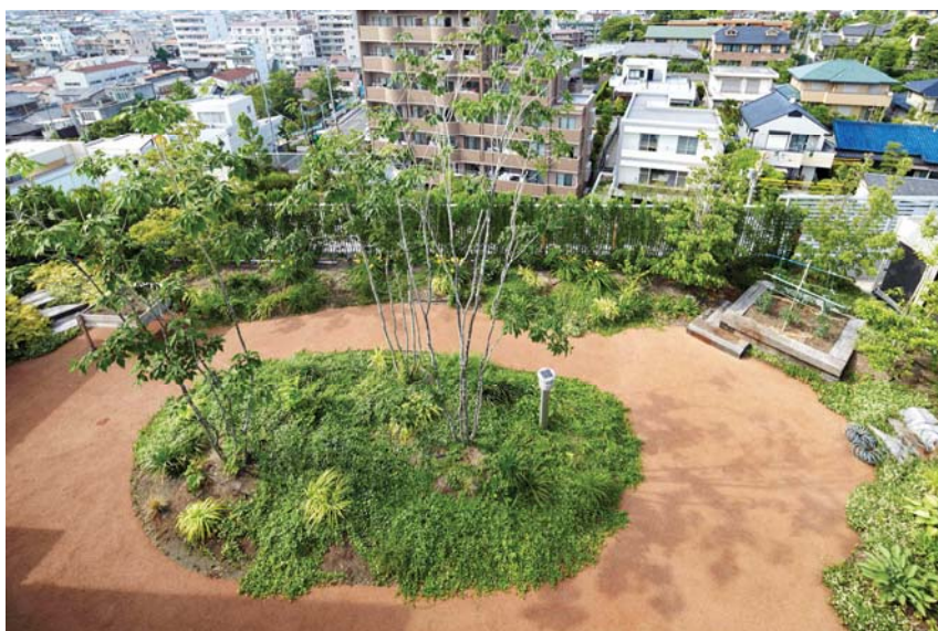
屋上テラスは生活リハビリテーションの場として活用されている。屋内からの眺めもよくなる。
