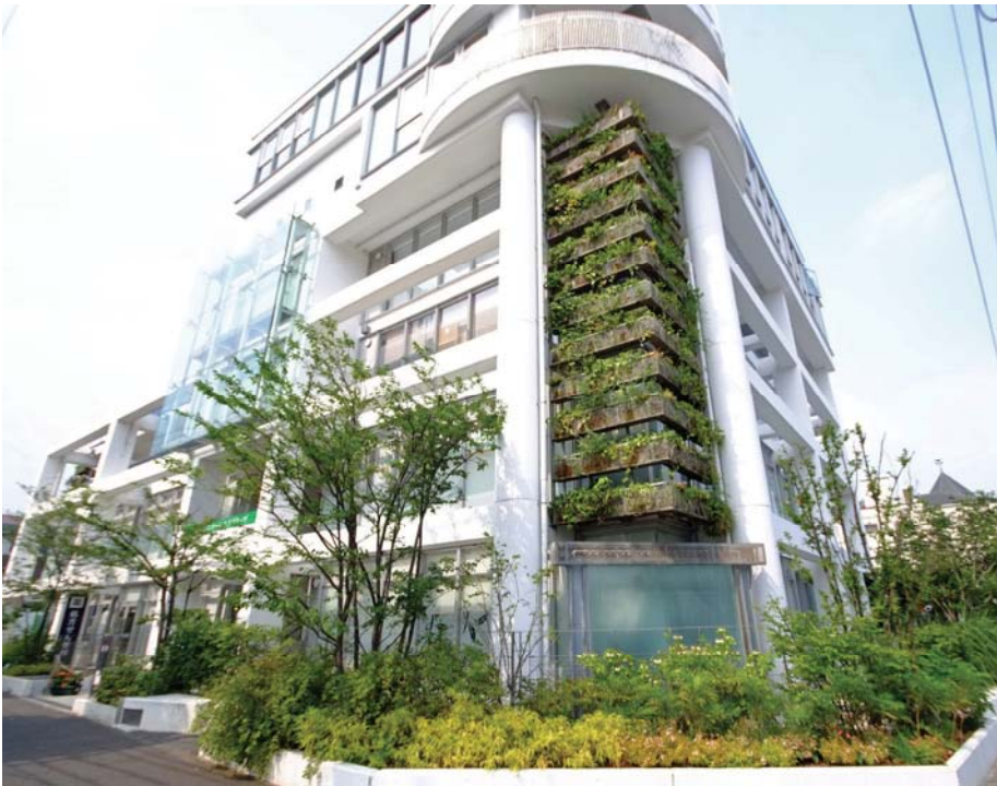
建物の角の壁面が緑化され、目立つ。
