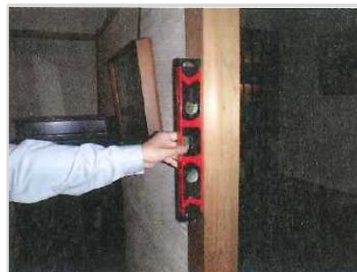
水平器による柱の傾きの計測
