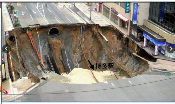
陥没の大きさ 幅 約27m×長さ 約30m×深さ 約15m
