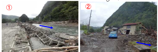
被災状況写真
