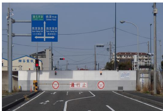
陸閘の設置例 (静岡県焼津漁港海岸)
