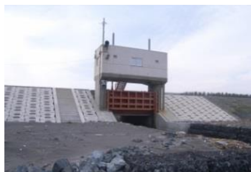
樋門の設置例 (青森県百石海岸)
