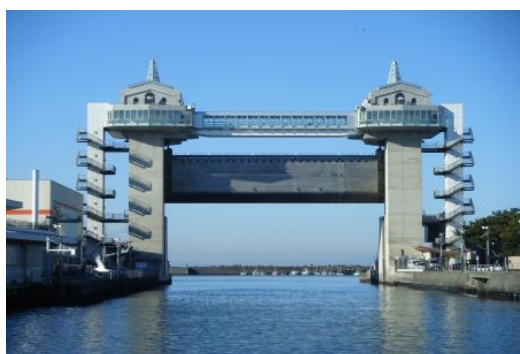
水門の設置例 (静岡県沼津港海岸)
