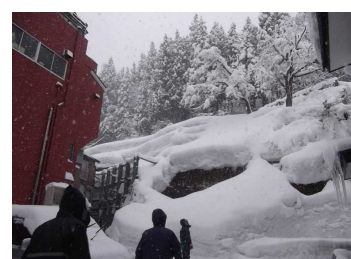
雪崩危険箇所点検(山形県)
