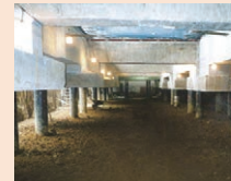
④手動ジャッキで鋼管杭を圧入し建物を仮受け
