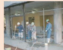
⑧鋼管杭を切断して撤去
