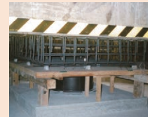
⑥免震装置を支える床のコンクリートを打設
