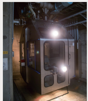
点検用モノレールがあるダムは珍しい
