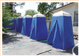
熊本地震時に設置されたマンホールトイレ (熊本市)
