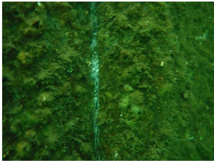
写真-2.2 白濁付着物（潜水 No. 1）
