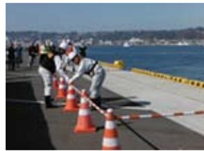
係留施設点検の結果、岸壁に損壊がみられる箇所を発見。二次災害を防ぐために、宮崎県により、立入禁止措置を行います。
