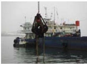
水中障害物調査により発見された沈下物を災害協定団体の起重機船により撤去し、航路の確保を行います。
