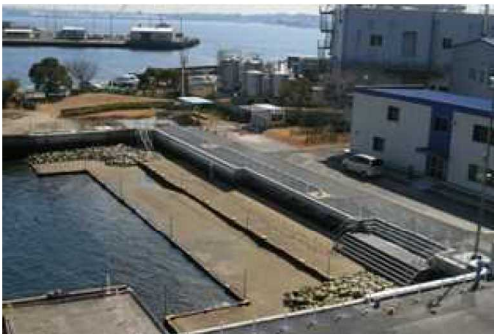
生物共生型港湾構造物の設置事例
