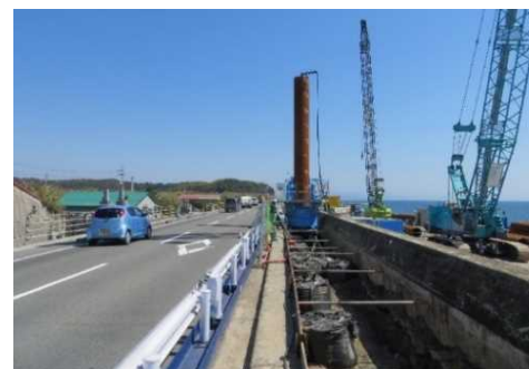
海岸堤防の耐震対策(高知県高知市)
