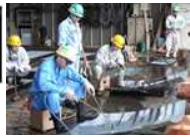
ぎょう鉄(鉄板曲げ加工)
