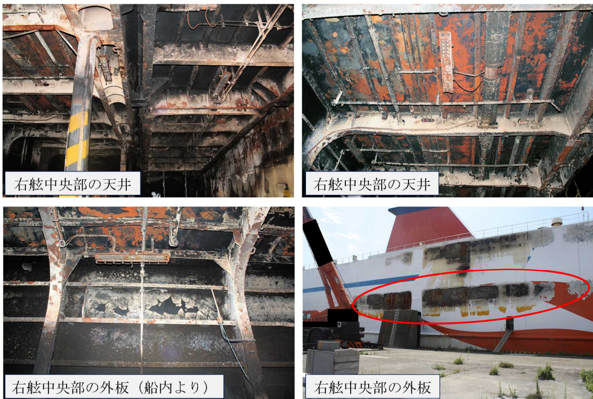
写真 1 第 2 甲板右舷中央部の損傷状況
