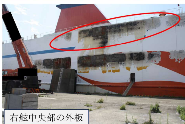
写真2 第3甲板右舷中央部の損傷状況
