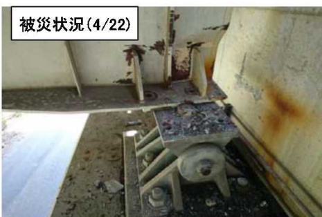
ゆふだけ 由布岳PA付近 並柳橋 桁及び支承損傷
