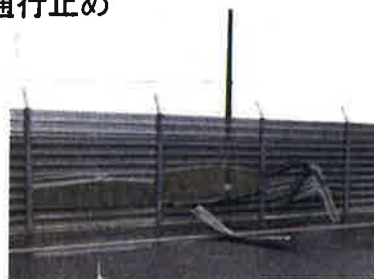
・冠水による臨港道路の一部区間通行止め
