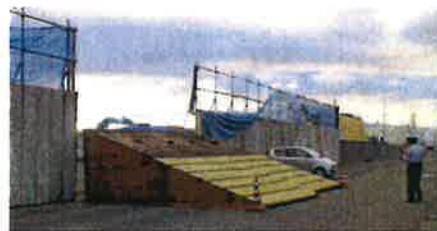
・冠水による臨港道路の一部区間通行止め
