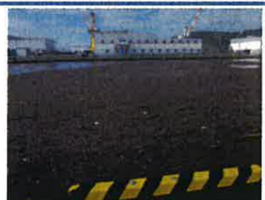
・-5.5m岸壁前面泊地に漂流物が漂着(利用に支障) ・冠水による臨港道路の一部区間通行止め
