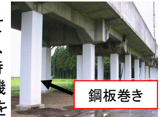
【高架橋の補強】
