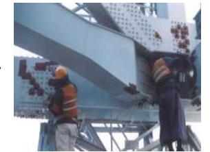
【橋りょうの重防食塗装】
