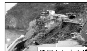
迂回トンネル造成
