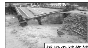
橋梁の補修補強
