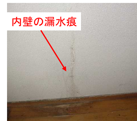
内壁：ひび割れより漏水が発生している
