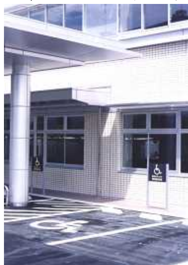
車いす利用者用 駐車場の整備
