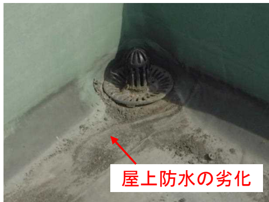
屋上(左)、天井(右)：屋上防水の劣化による漏水により、天井の剥離が発生している
