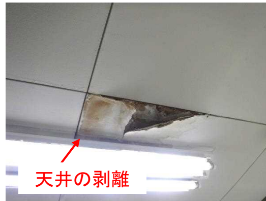
屋上(左)、天井(右)：屋上防水の劣化による漏水により、天井の剥離が発生している
