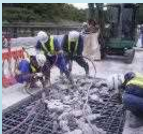
▲修繕・耐震補強
