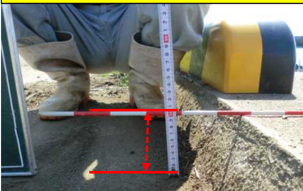
たのうらこう 田浦港（岸壁舗装沈下）
