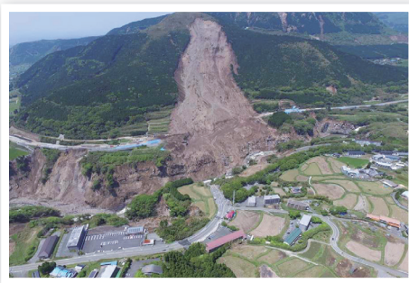
阿蘇大橋付近の斜面崩壊の様子(提供:国土地理院)
