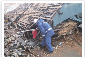
建築物の応急危険度判定の様子
