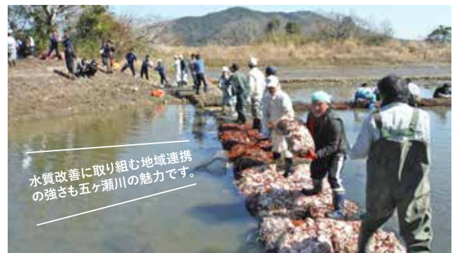
水質浄化作用のあるカキ殻や竹炭を設置する行政・市民等の活動 (写真提供:九州地方整備局 延岡河川国道事務所)
