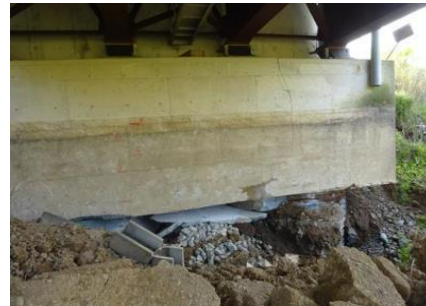
写真-4 県道熊本高森線・ たかもり 俵山大橋における橋台の沈下
