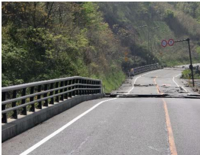
写真-4 県道熊本高森線・ たかもり 俵山大橋における橋台の沈下
