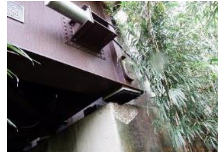
写真-5 県道熊本高森線・ おおきりはた 大切畑大橋におけるゴム支承の損傷（左） と国道325号・ みなみあそ 南阿蘇橋におけるダンパー取付部の損傷（右）
