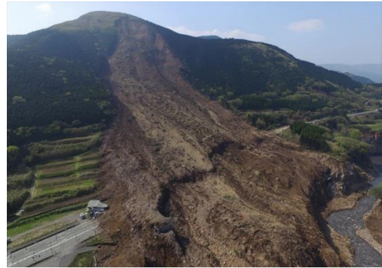
みなみあそ (国道57号南阿蘇村) 写真-3 斜面崩壊の状況
