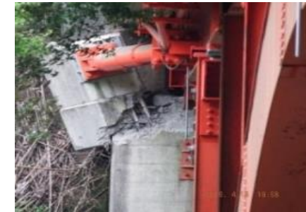
写真-5 県道熊本高森線・ おおきりはた 大切畑大橋におけるゴム支承の損傷（左） と国道325号・ みなみあそ 南阿蘇橋におけるダンパー取付部の損傷（右）
