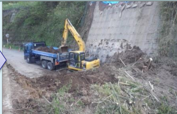
■重機による道路啓開作業を実施
