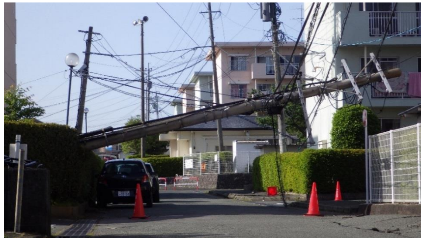
写真-12 電柱の倒壊 (町道・熊本県益城町宮園地先)
