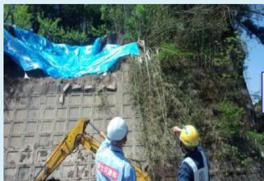
■被災状況を現地で調査
