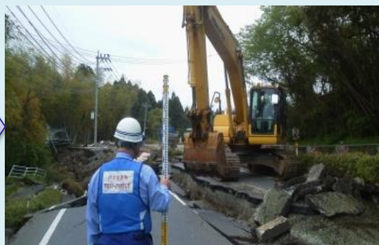
■重機による盛土復旧作業を実施
