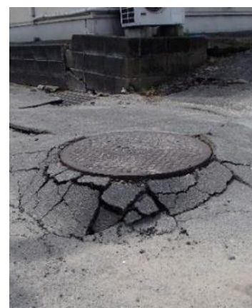
写真-13 電柱の沈下やマンホールの浮き上がり及び周辺地盤の沈下 (左:町道・熊本市南区近見地先、右:町道・熊本県益城町寺迫地先)
