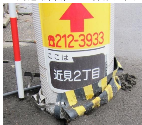
写真-13 電柱の沈下やマンホールの浮き上がり及び周辺地盤の沈下 (左:町道・熊本市南区近見地先、右:町道・熊本県益城町寺迫地先)
